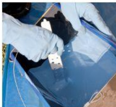
7 – Diluição da tinta na bandeja.
