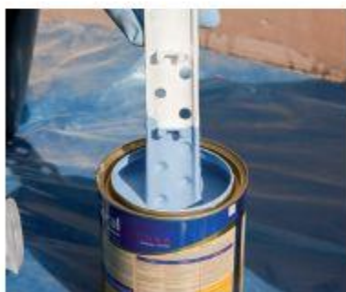
6 – Mistura da tinta ainda no seu recipiente, antes de ser colocada na bandeja.
