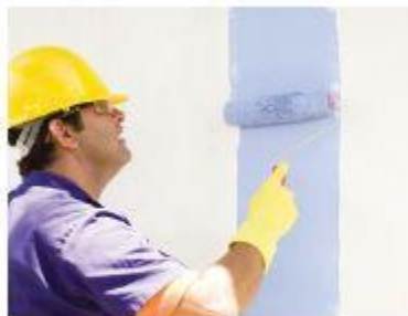
9 – Aplicação da primeira demão da tinta, com rolo de lã.
