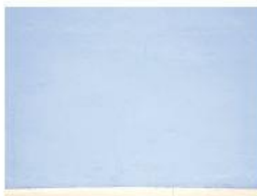
11 – Parede pronta após aplicação da segunda demão.
