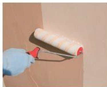
5 – Aplicação de fundo preparador ou seladora, dependendo das condições da base.
