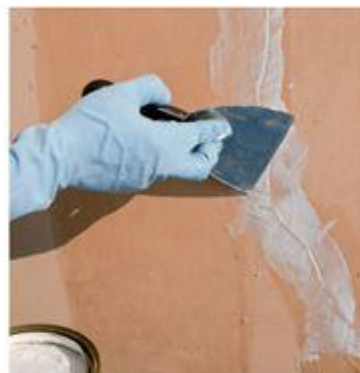
3 – Com a superfície seca e limpa, aplicação de massa niveladora (massa corrida) para correção de imperfeições.
