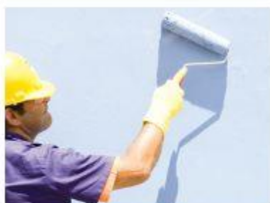
10 – Aplicação da segunda demão após a secagem da tinta da primeira demão.
