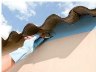
8 – Início da pintura pelo encontro de paredes e teto ou cobertura.
