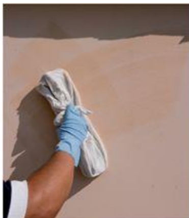
1 – Limpeza de manchas da parede com pano umedecido.
