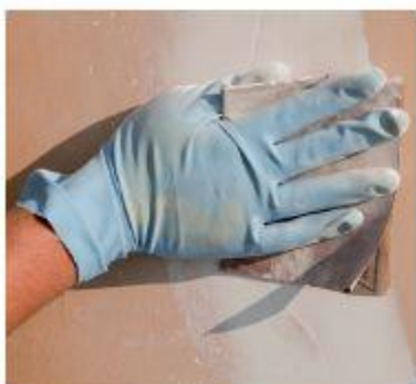
4 – Execução de lixamento para uniformizar a superfície.
